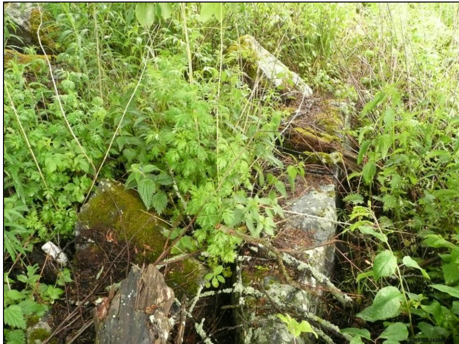
Vanhan myllyn rakenteita.
